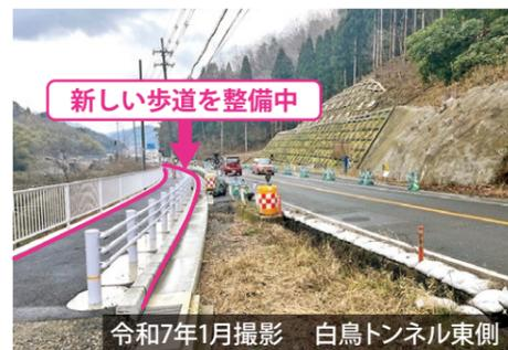
新トンネルの供用と併せて、東西坑口付近の歩車道整備が実施されています。暫定供用に向けて、東側では約200m、西側では約480mが整備されます。
