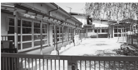
移設された東保育所
