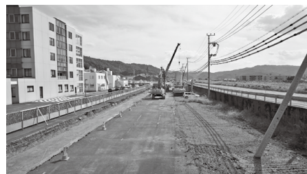
工事が進む西舞鶴道路（倉谷地区）
