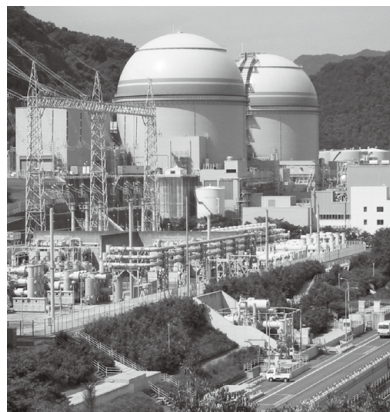
舞鶴市に隣接する高浜発電所
