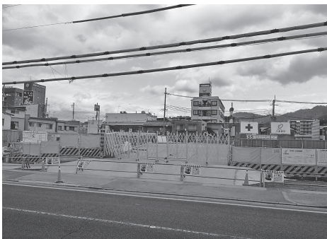
建設工事中の複合医療介護施設
