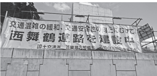
工事進む西舞鶴道路
