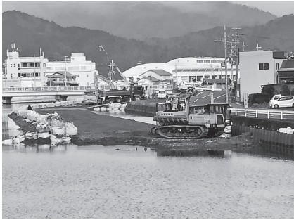
浸水対策が進捗する伊佐津川の護岸工事
