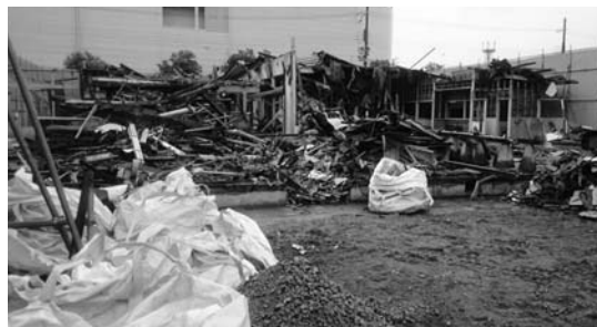
除却工事が進む児童福祉施設
