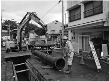
老朽化した水道管の敷設替整備
