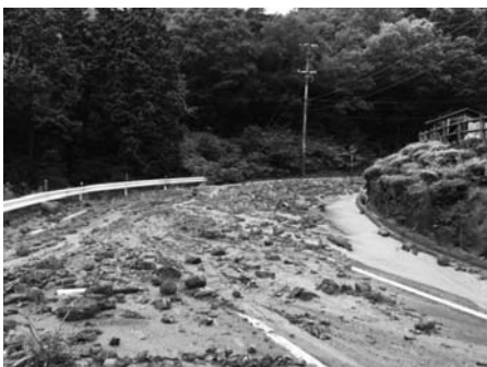
市民の安全を確保するための災害復旧
