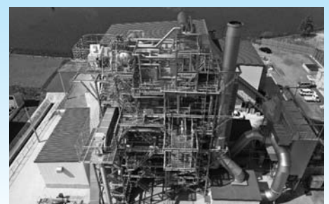
木質バイオマス発電施設
