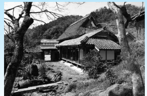
大庄屋上野家
