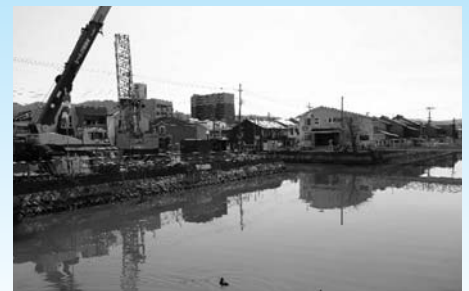
大手ポンプ場の建設現場
