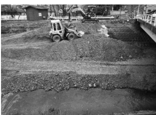
住民要望により実施の浚渫工事
