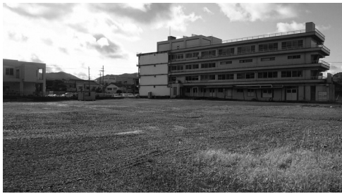
複合化される旧市民病院西棟
