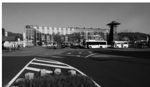
西舞鶴駅西口広場
