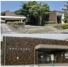
築30年以上経過し、老朽化が進んでいる東西図書館
