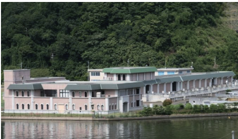
下水道東浄化センター
