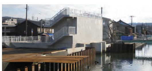
大手ポンプ場の土木工事が完了
