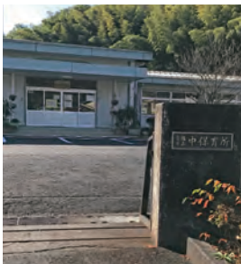
老朽化が進む市立中保育所
