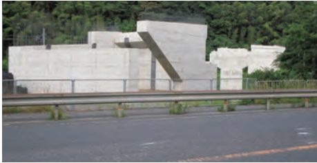
着々と進む国道27号西舞鶴道路工事
