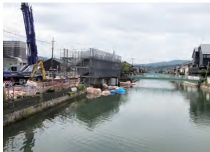
整備が進む高野川
