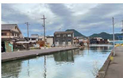
早期建設が期待される静溪ポンプ場の現場
