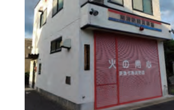
地元で整備いただいている 消防分団施設
