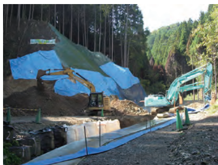
台風7号からの復旧復興作業状況
